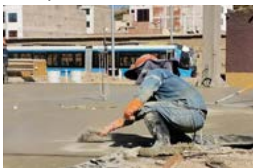
Ilustración 5. Proyecto “Mi Tren” Cochabamba, en construcción
