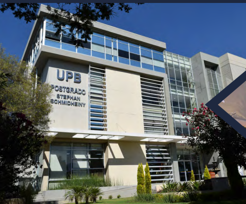
Edificio de Postgrado "Stephan Schmidheiny" Campus Julio León Prado - Cochabamba
