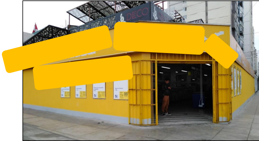
Figura 2: Fachada de primer proyecto retail.
